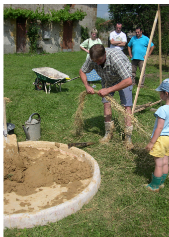
Technique de la bauge © Maisons Paysannes de France
