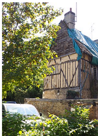
Maison de l'île du Canada : murs en torchis © Frank Selesniew via Wikimedia Commons
