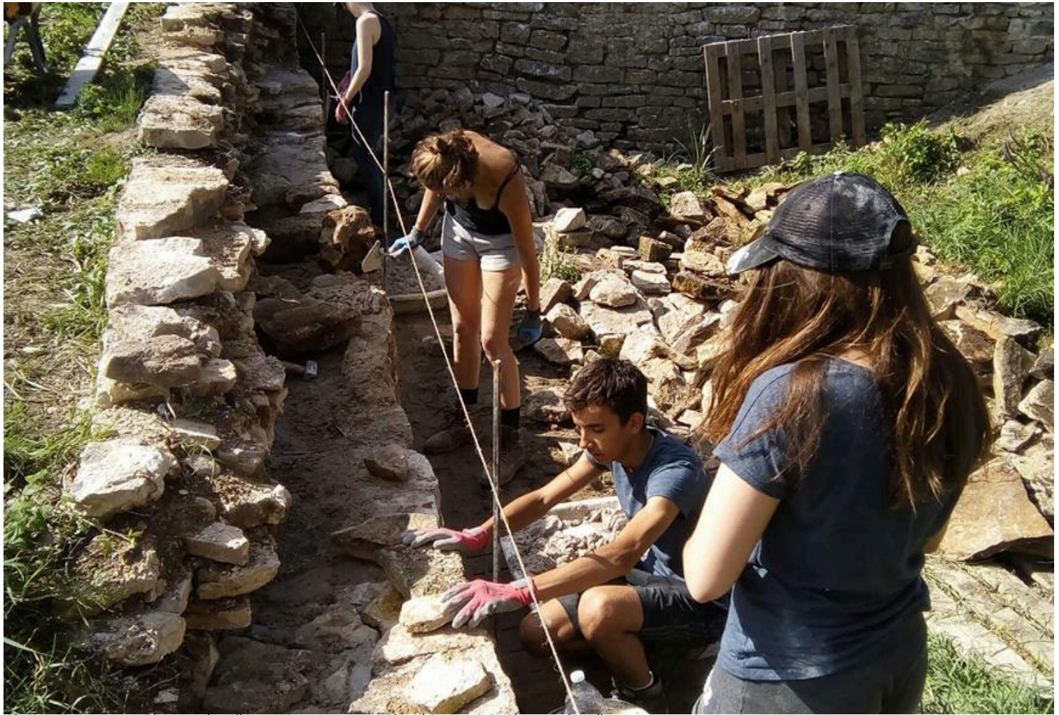
Chantier Rempart au Château de Villars, à Saint-Parize Le Chatel (Nièvre) © Château de Villars
