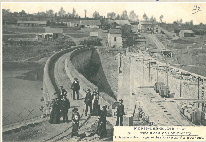
Carte postale des années 1900 montrant l'ancien barrage à gauche et le nouveau en construction à droite.
