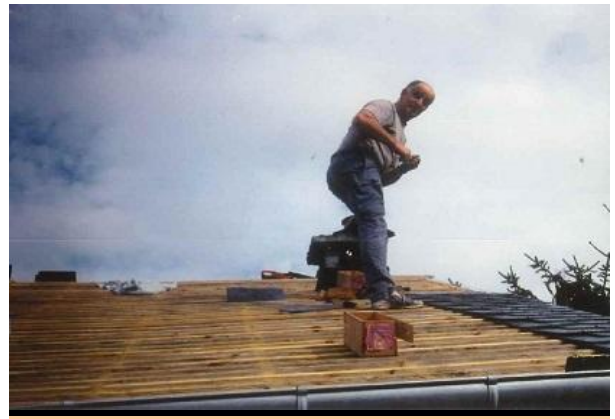
Joël Monteil réalisant une toiture en ardoise
