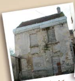
Maison avant travaux
