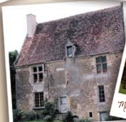
Manoir avant travaux - Orne
