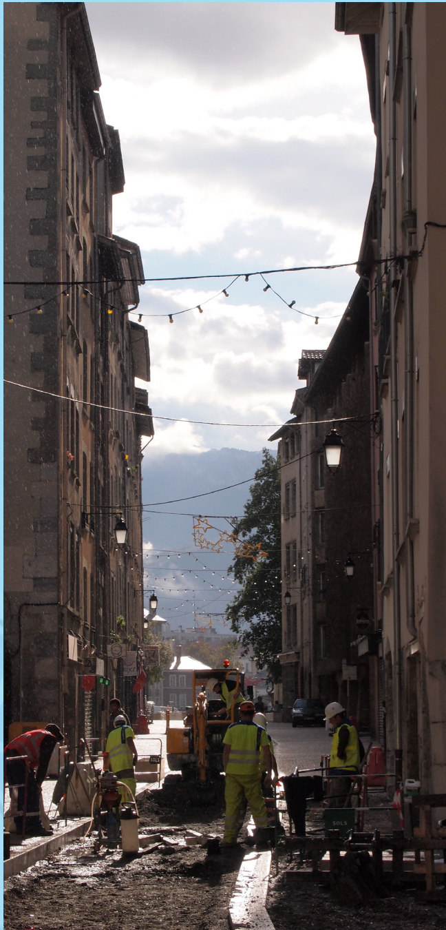
La rue Saint Laurent en cours de réaménagement
