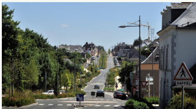
Après : entrée de ville rue de Bretagne
