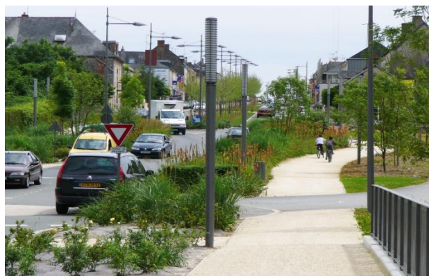
Après : traversée de la ville Avenue de la Libération
