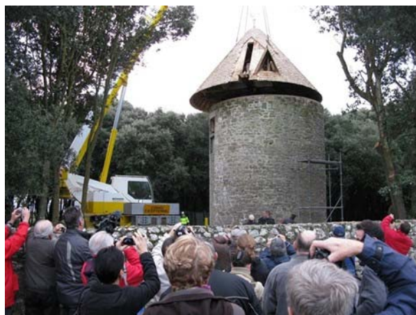
Repose de la charpente, décembre 2011
