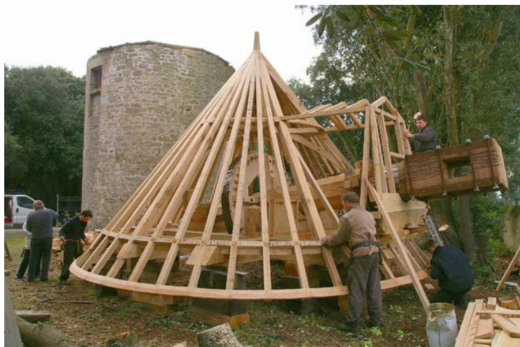
Construction de la charpente, décembre 2011
