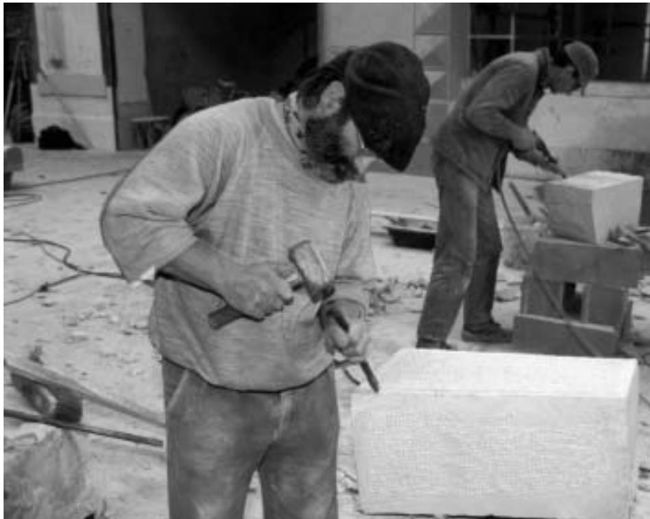
Bayonne : Atelier de Taille de pierre. Après calepinage et fiche de débit, finitions en fonction de l'architecture de l'édifice et des différents outils (layage smillage - bouchardage)
