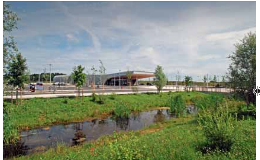
Gare de Belfort-Montbéliard TGV.
