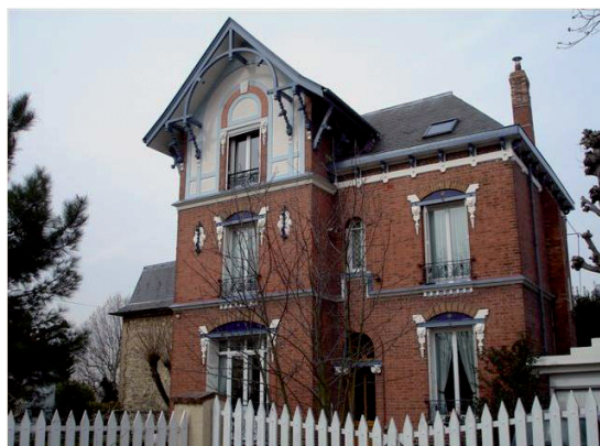
Villa restaurée dans le cadre d'un partenariat entre la FP et la ville d'Enghien-les-Bains (ZPPAUP)
