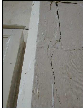
*Le ménage permet de repérer certains désordres : c'est au cours du ménage que l'on peut repérer les petits débris au bas d'une fissure, signes d'une fissure récente.*
