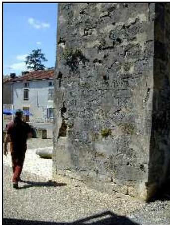
*Sur les bâtiments anciens, un enduit à la chaux est nécessaire : il laisse respirer le mur, faute de quoi la pierre se disloque sous l'enduit, qui finit également par perdre son adhérence.*
