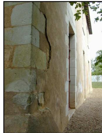
*Décollement d'enduit suite à des remontées d'eau. ou d'un enduit non adapté.*
