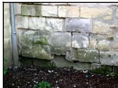
*Gouttière débouchant au pied de l'église—pas de drainage, infiltration.*
