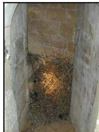
*Un accès aux combles encombré de brindilles est un facteur d'incendie et une entrave à la vérification des charpentes.*
