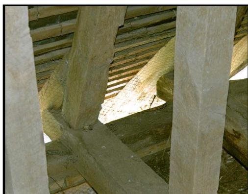
*Un grillage anti-volatile a été posé entre la toiture et l'arase des murs.*
