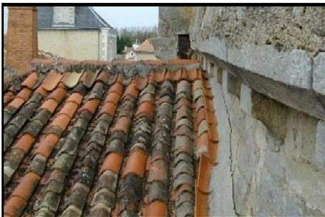
*Le solin est le point de jonction entre deux murs—son étanchéité est essentielle, car ils protègent le bâtiment des infiltrations.
