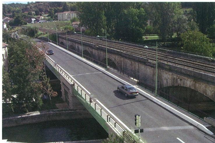
Pont sud et pont rail
