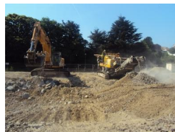
Printemps 2010 : Démolition de la Salle du canal
